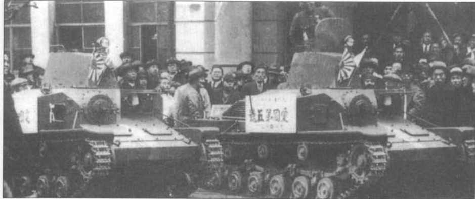
Легкий кавалерийский танк «тип 92 Кей Синша» раннего выпуска, ходовая часть включает по шесть опорных катков и по три поддерживающих гусеницу ролика на борт. Вооружение - два пулемета калибра 6,5 мм. На крайнем слева танке открыт лючок в рубке стрелка, предназначенный для метания через него ручных гранат.
