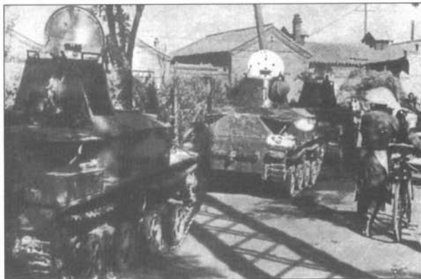
Легкие кавалерийские танки «тип 92 Кей Синша» поздней постройки с новой ходовой частью - 4 опорных катка и два поддерживающих гусеницу ролика вместо шести катков и трех роликов.
