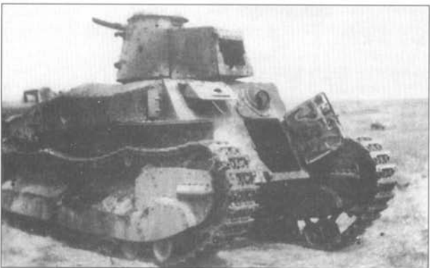
Танки «тип 89» («2594») поздней постройки, подбитые американцами. Пробиты от снарядов обведены светлым.
